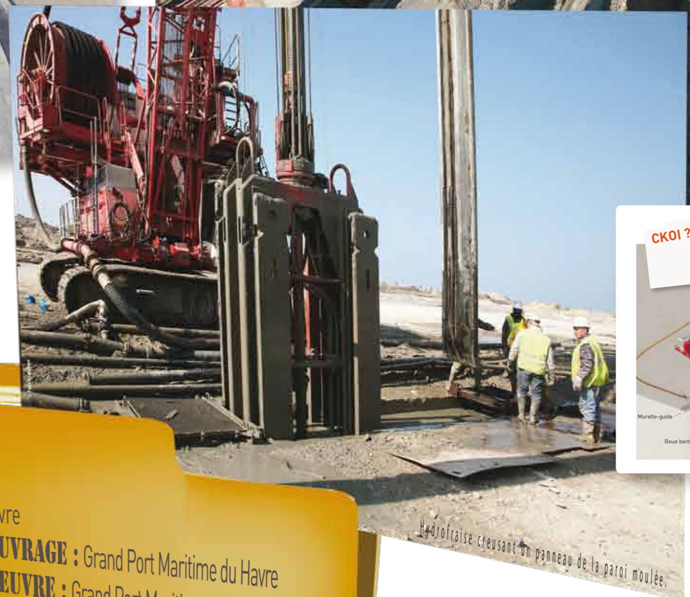
Les quais en cours de construction.
