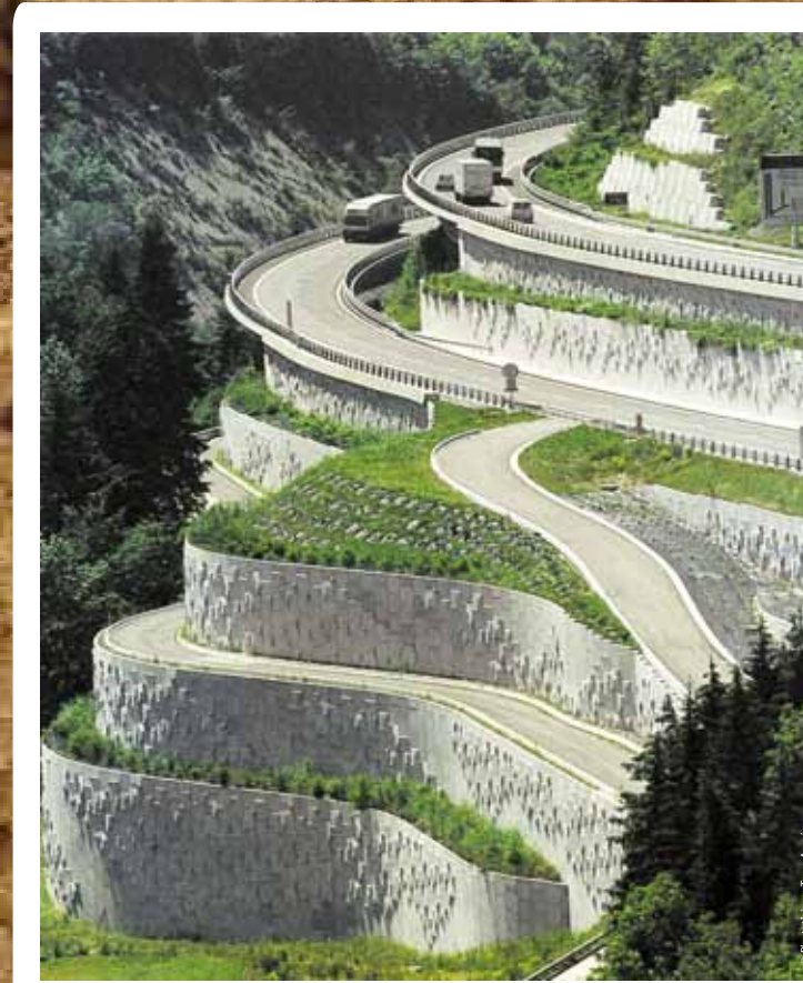
Des murs en Terre Armée sur l'A40.
