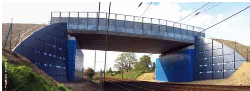
Un parement original pour une voie ferrée !
